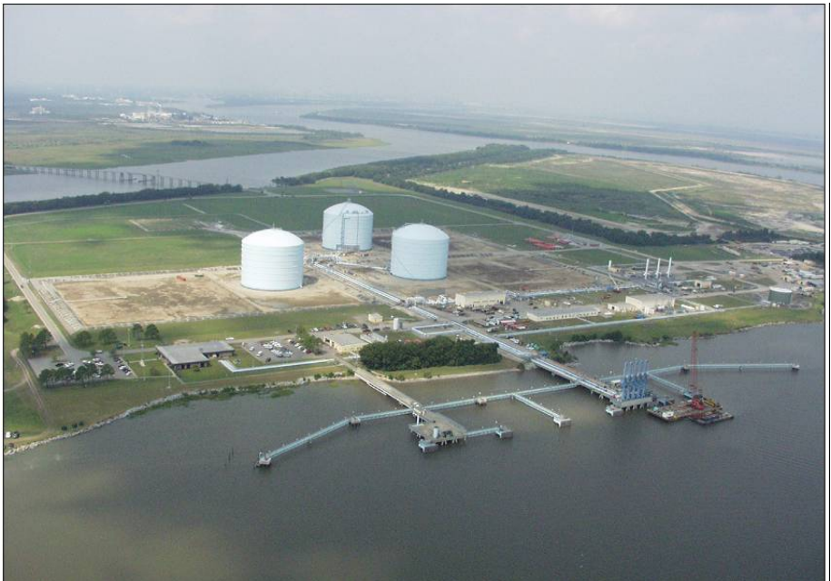
Cove point LNG terminal
